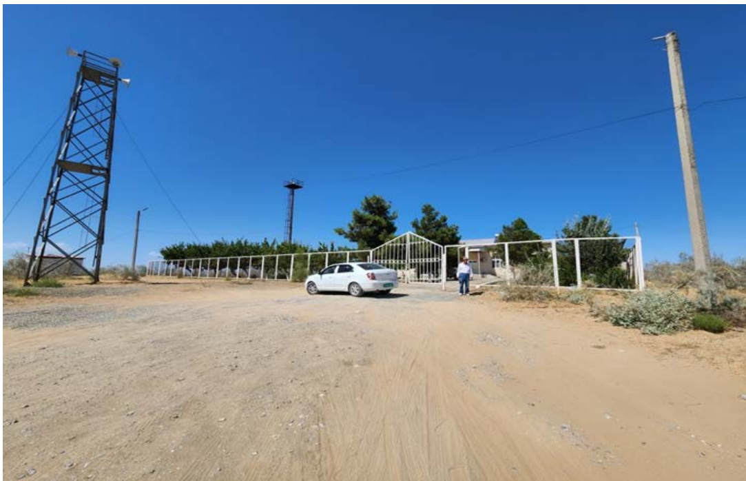
Территория диспетчерской службы Арнасайского водохранилища
