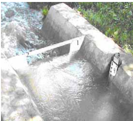
Рис. 3.1. Водослив Чиполетти (вид с верхнего бьефа):
