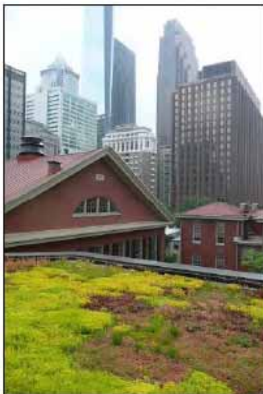
«Зеленая крыша», собирающая дождевой сток, в Филадельфии (источник: Управление по охране окружающей среды)
