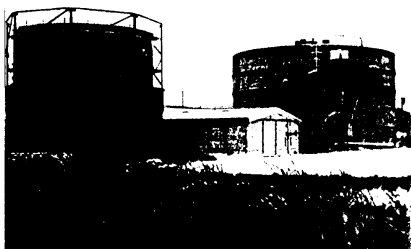
Рис. 12.2. Промышленные дайджестеры для производства биогаза из навоза свиней в Шатийон-ан-Ванделэ, Иль-эт-Вилэн (Франция)
