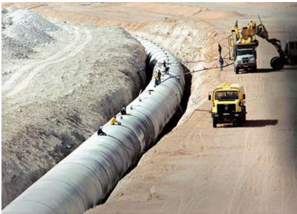
Рис. 4.5 Трубопровод в процессе строительства.
