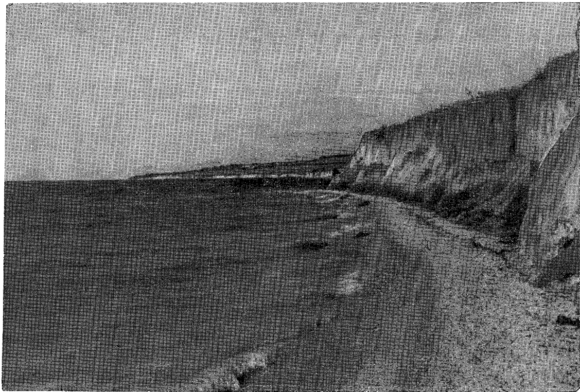
Рис. 27. Каховское водохранилище. Разрушение берега.
