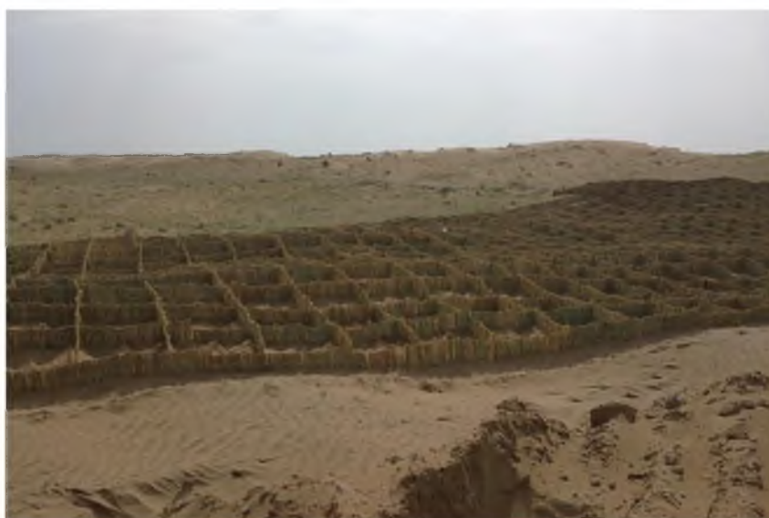
Рисунок 2 – Установленная механическая защита вдоль железной дороги
