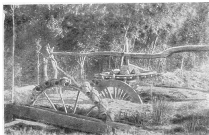
Для орошения часто приходилось поднимать воду из глубоких каналов на поля примитивным водоподъемным колесом (чигирь), приводимым в движение животными.(Фото автора.)
