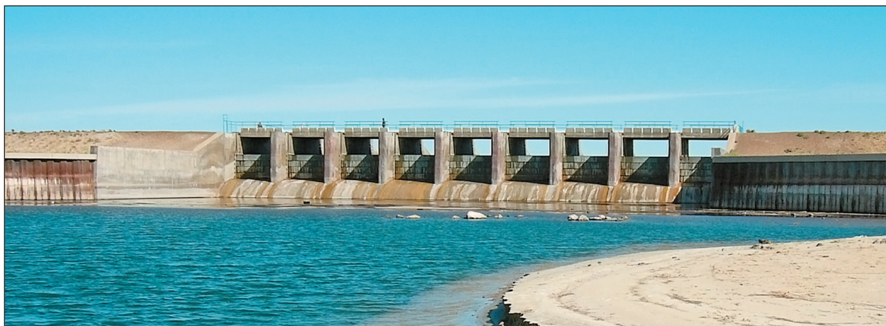
Водосбросное устройство Кокаральской плотины летом. Сток воды из Малого Арала отсутствует.
