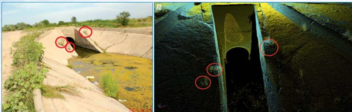
Рисунок 3. Входной оголовок участка Каскеленского канала на ПК1640 (слева) и трехмерная геодезическая съемка того же участка (справа). Красными овалами выделены одни и те же места с растительностью на откосах.
