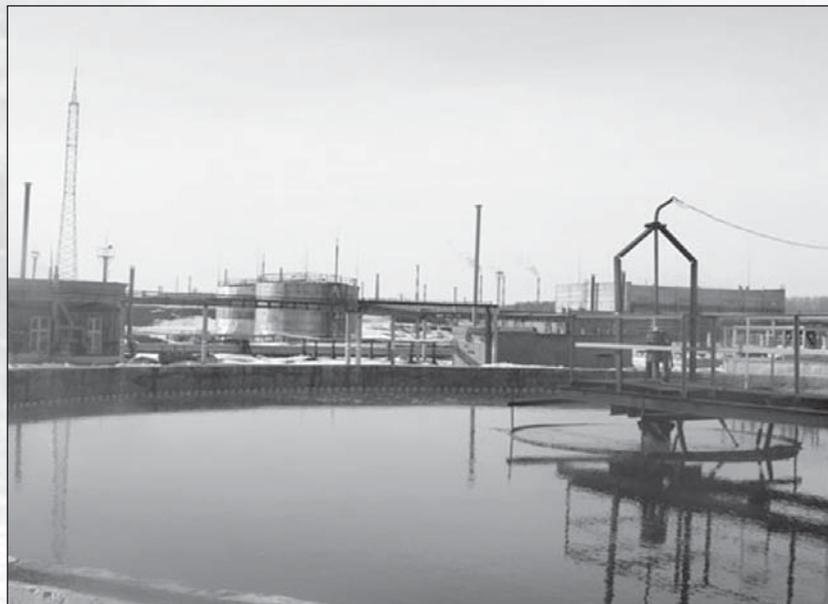
Безреагентный метод целесообразно применять для очистки подземных вод от Fe и Mn в небольших концентрациях. Он заключается в предварительном аэрировании воды с последующим фильтрованием через зернистую загрузку.
