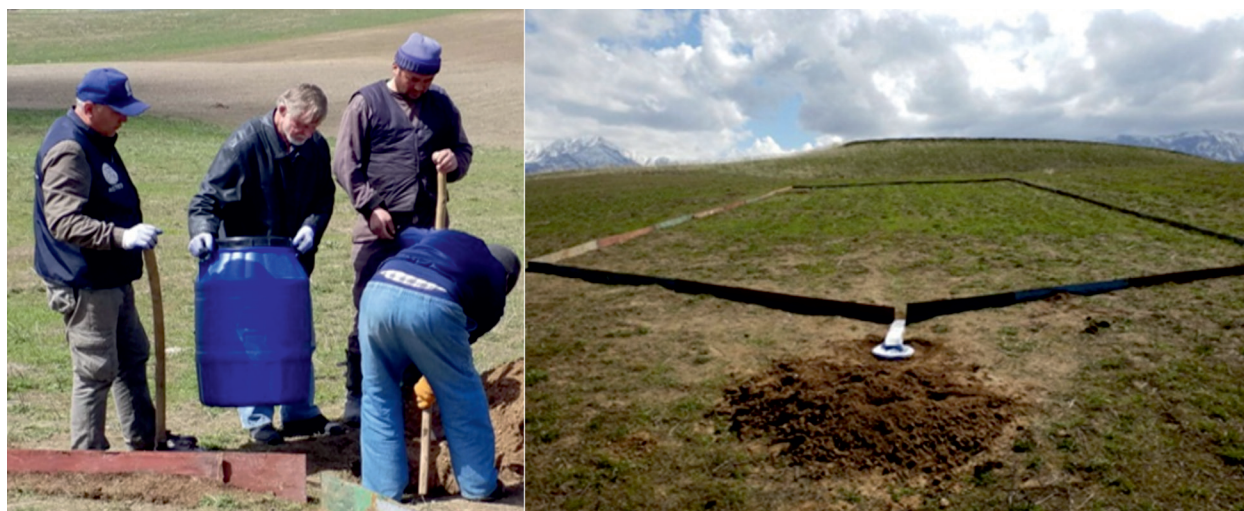
Рисунок 3. Устройство стоковых площадок в Девайтчицком районе
