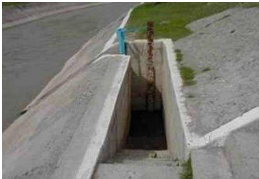
**Рис. 2. Успокоительный колодец с уровнемерной рейкой на гидрометрическом посту магистрального канала**
