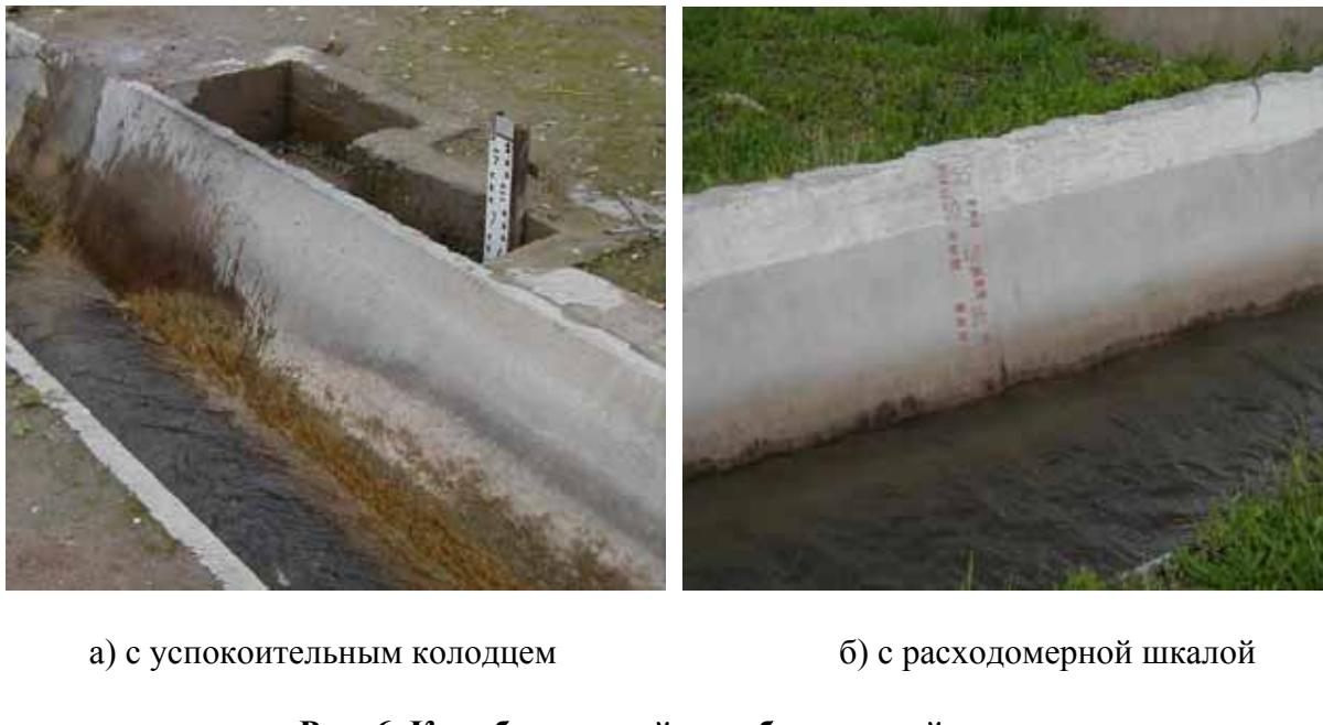
**Рис. 6. Калибронный параболический лоток**
