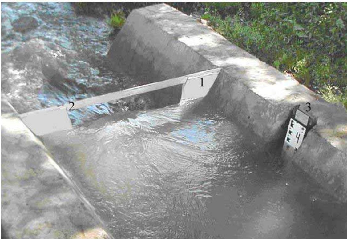
Рис. 4. Трапецидальный водослив
