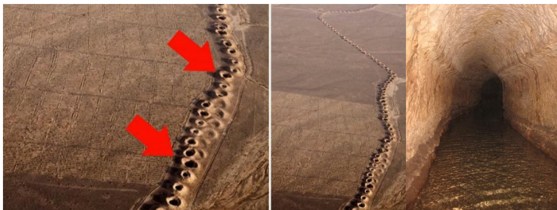
Рис. 3. Пример системы очистительных колодцев по пути следования подземного водовода – кариза Источник: Мукимов и соавторы, 1996; Мамаджанова, 2017
