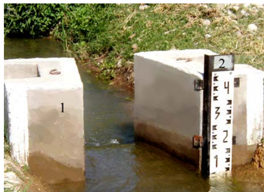
Рис. 1.4. Водомерный лоток САНИИРИ
