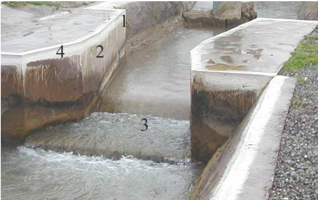
Рис. 2. Головной гидропост (лоток Паршала) на канале второго порядка
