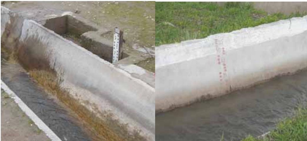
Рис. 8. Градуированный параболический лоток
