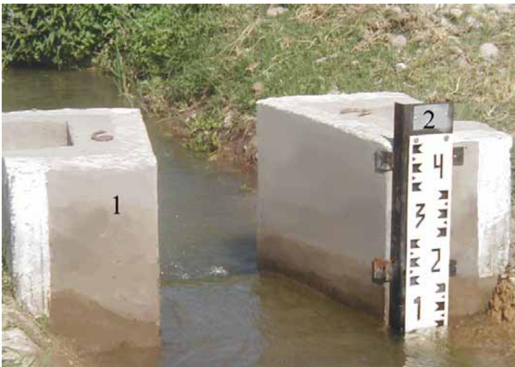
Рис. 3. Водомерный лоток САНИИРИ, подводящая часть
