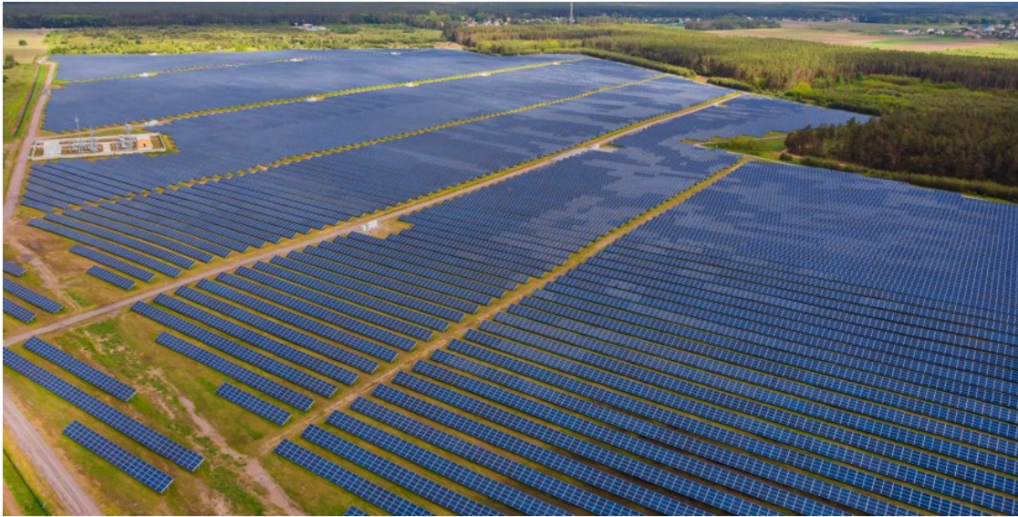
Солнечная электростанция Fundão
