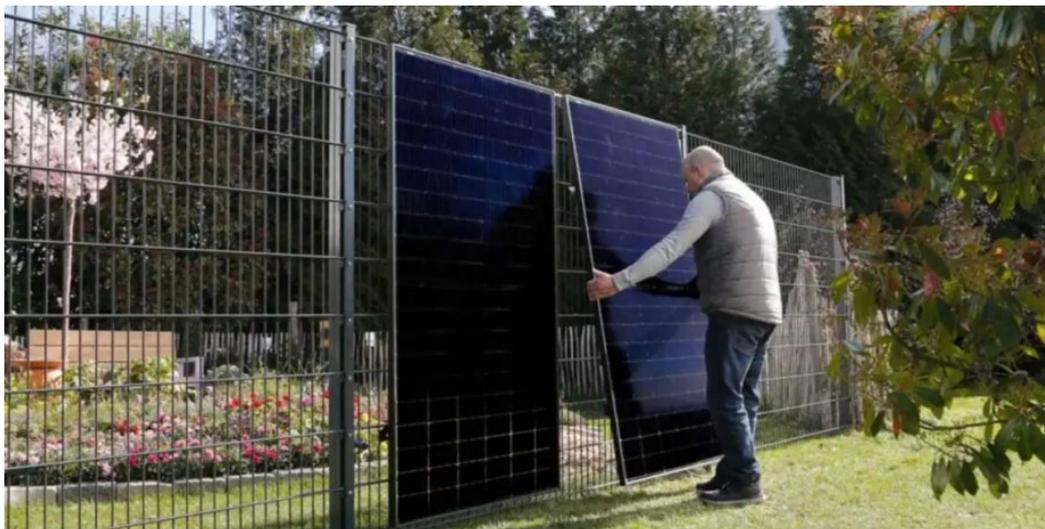
Энергетическую мощность устройства обеспечивает большая пластина, состоящая из шести панелей, которые вырабатывают около 2 кВт ч, чего достаточно для питания некоторых приборов, снижения расходов на электроэнергию и внесения посильного вклада в сокращение выбросов углерода в энергетическом секторе.
