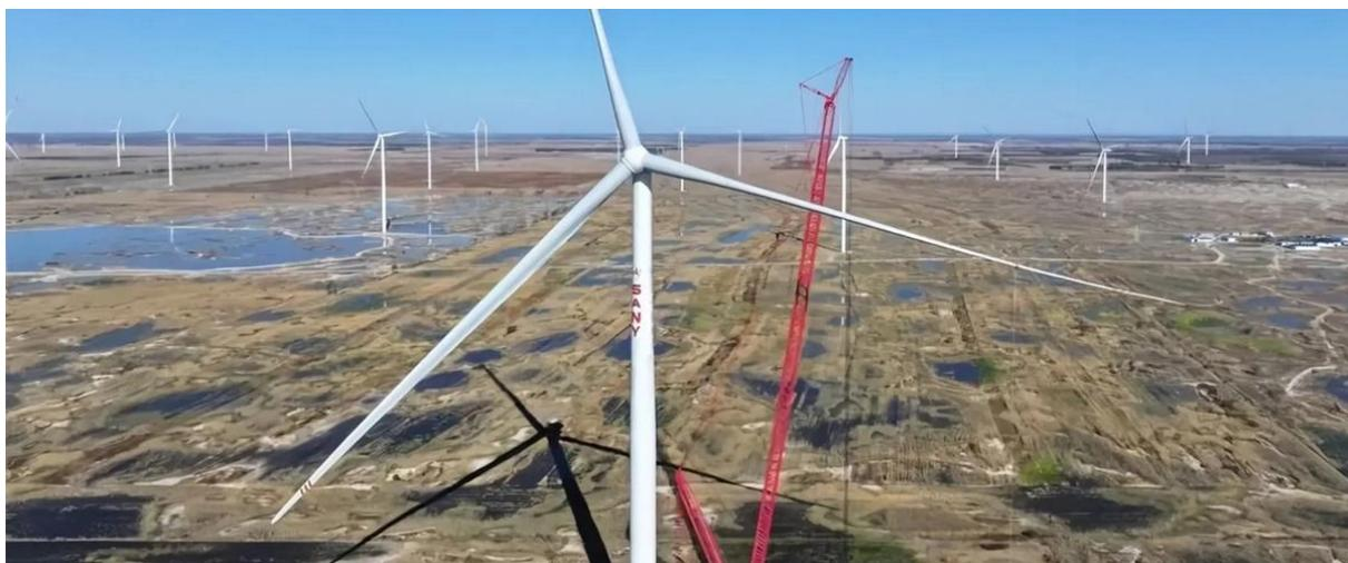
Турбина SI-270150 оснащена лопастями длиной 131 м, что позволяет охватить площадь 57 256 м<sup>2</sup>. Это эквивалентно 11 американским футбольным полям. Sany также установила рекорд по диаметру ротора наземной турбины — 270 м. Предыдущий рекорд установлен турбиной Goldwind мощностью 12 МВт, запущенной в 2023 году. Диаметр ротора этой установки составлял 240 м.
