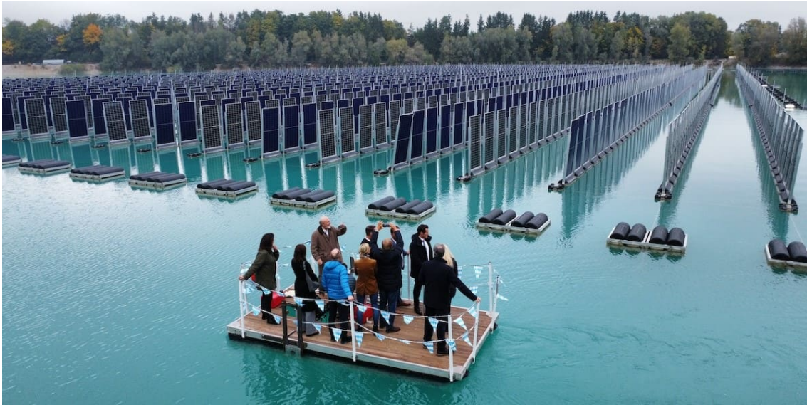
Вертикальная плавучая солнечная электростанция SINN Power
