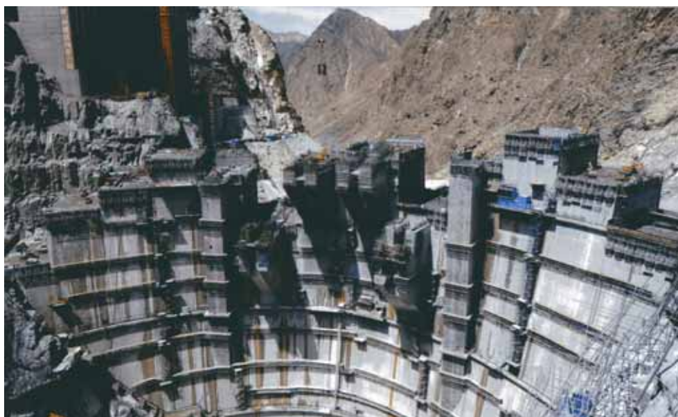
Рис. 14. Лаксива ГЭС (во время строительства), расположена в провинции Кингхай. Одна из самых крупных ГЭС на Желтой реке
