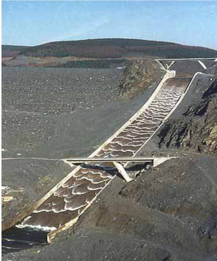
Водосброс плотины Ллина Брайана в Уэльсе
