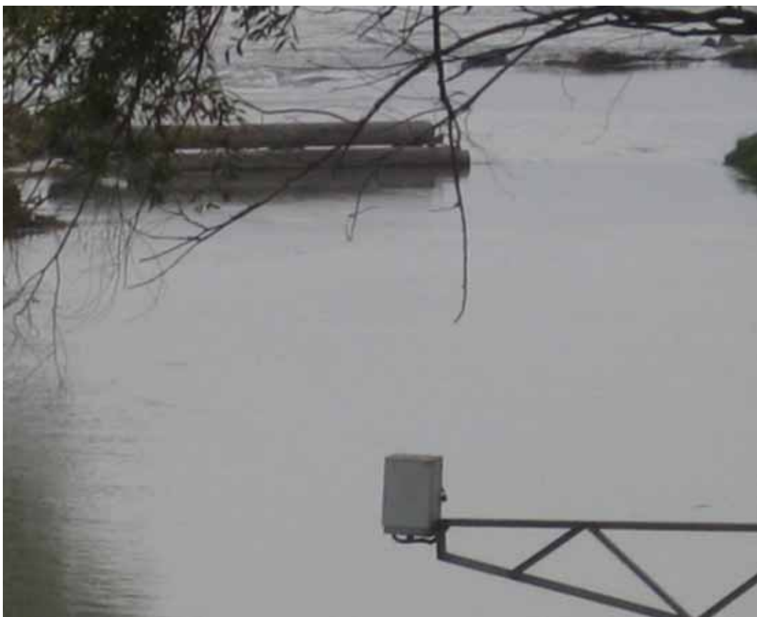
Рис. 2. Установка датчика уровня воды
