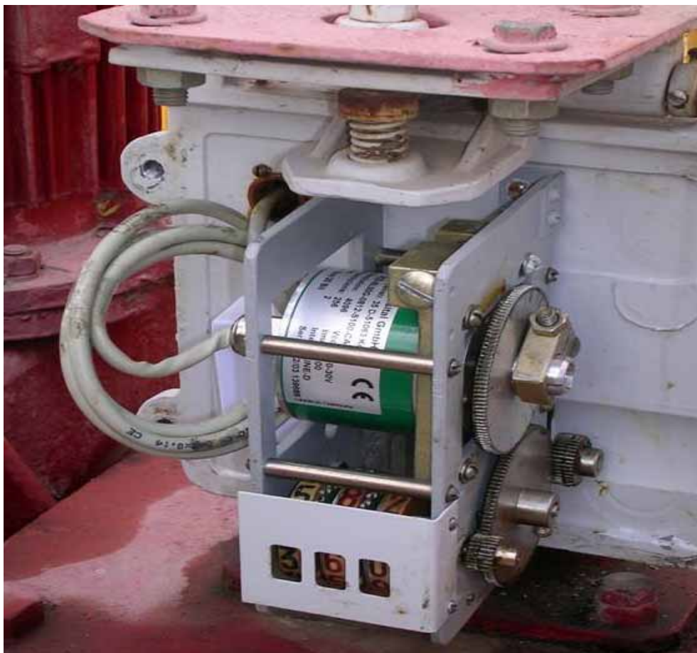
Рис. 3. Датчик положения затвора (ДПЗ)
