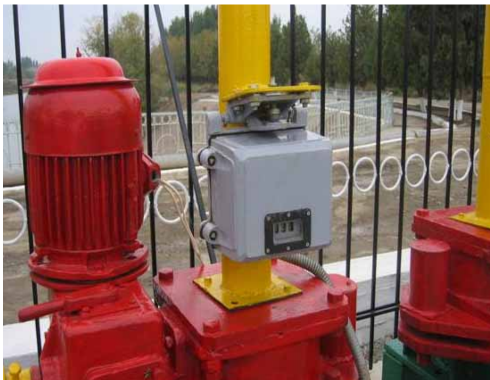
Рис. 4. Установка ДПЗ на винт затвора
