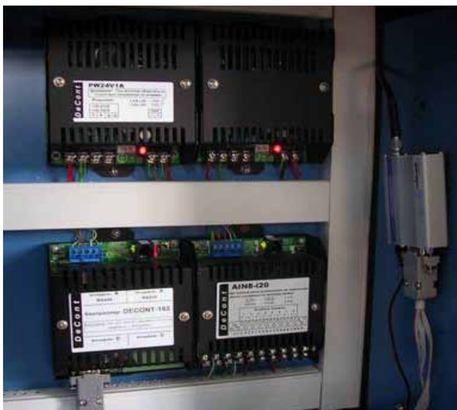
Рис. 9. Установка модема Wavcom MI306B
