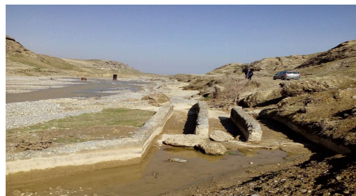
Головной водозабор канала Хитой.
