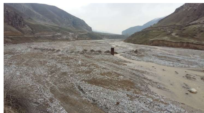
Место створа плотины водохранилища «Исфана»
