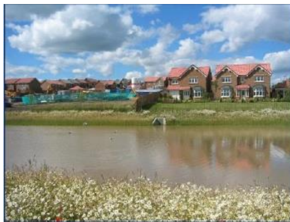
Рисунок 1.5.2: пример технологии хранения - отстойный пруд (фото использовано с разрешения университета Абертей)
