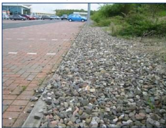
Рисунок 1.5.3: пример технологии просачивания - дренажный фильтр (фото использовано с разрешения университета Абертей)
