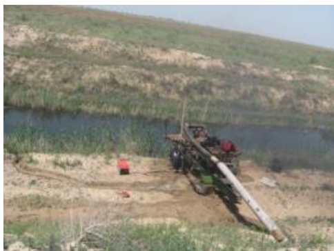
Рисунок 5.11.13 – Забор коллекторно-дренажных вод с Арнасайского и Сардобинского коллектора в Махтааральском массиве (Фотограф: Р. Бекбаев)
