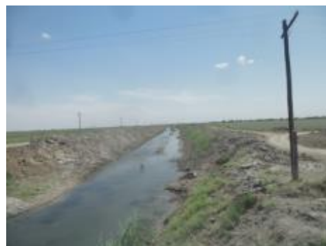
Рисунок 5.11.11 – Открытый коллектор Д-3 и скважина вертикального дренажа СВД -18 (Махтааральский ирригационный система, 2013; Фотограф: Р. Бекбаев)
