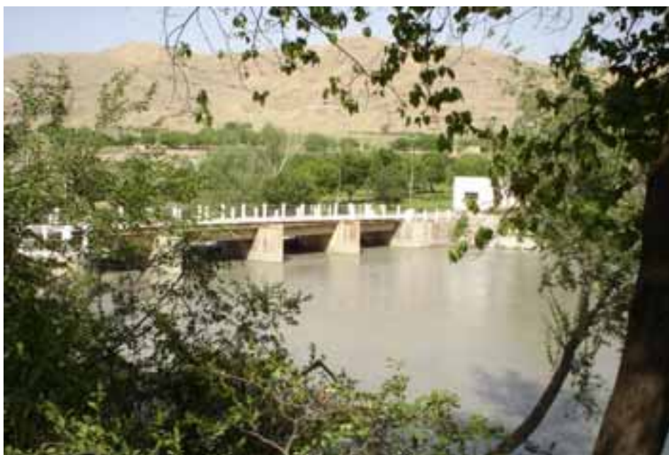
Рис. 2. Головное сооружение канала Ходжабакирган
