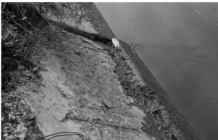
**Рисунок 4 – Повреждения защитного покрытия из бетонных плит на участке канала Бг-Р-7 (автор фото О. А. Баев)**
