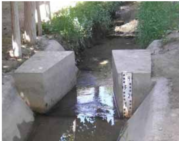
Рис. 6. Водомерный лоток САНИИРИ 1 – входные открылки, 2- гидротехническая рейка.
