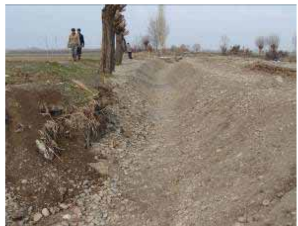
Прокладка проектного профиля в грунте
