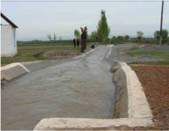
Завершенный головной участок канала
