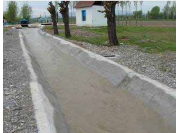
Створ гидропоста после реконструкции
