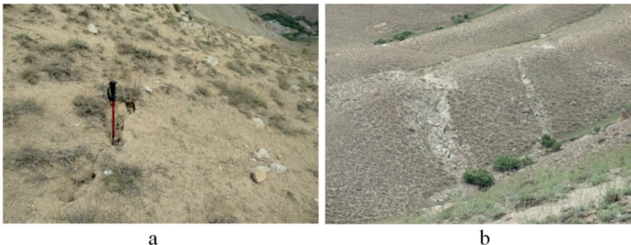
Рис. 23. Экзогенные оползневые трещины, простирающиеся вдоль головы оползня на участке в районе кишлака Себзор. Погруженная часть треккинговой палки соответствует 120 см. Фото О.Н. Мавлоназарова
