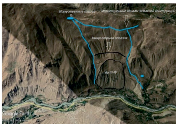
Рис. 21. Общий вид оползнеопасного участка в районе кишлака Себзор. Подложка: снимок с сервиса Google Earth
