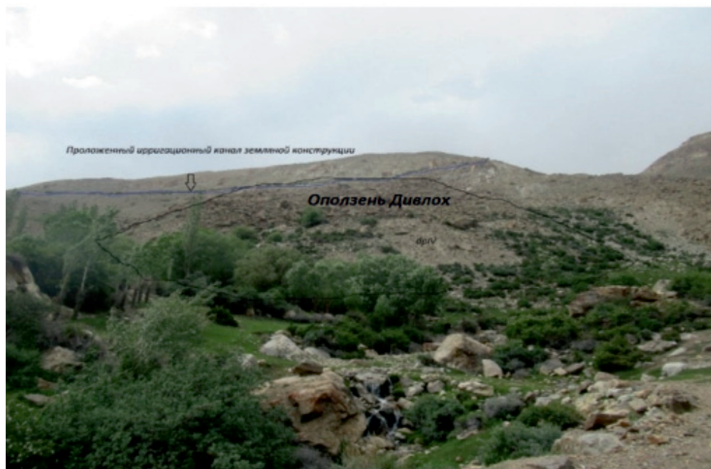
Рис. 5. Оползень на участке Дивлох. Фото Г.В. Шафиева
