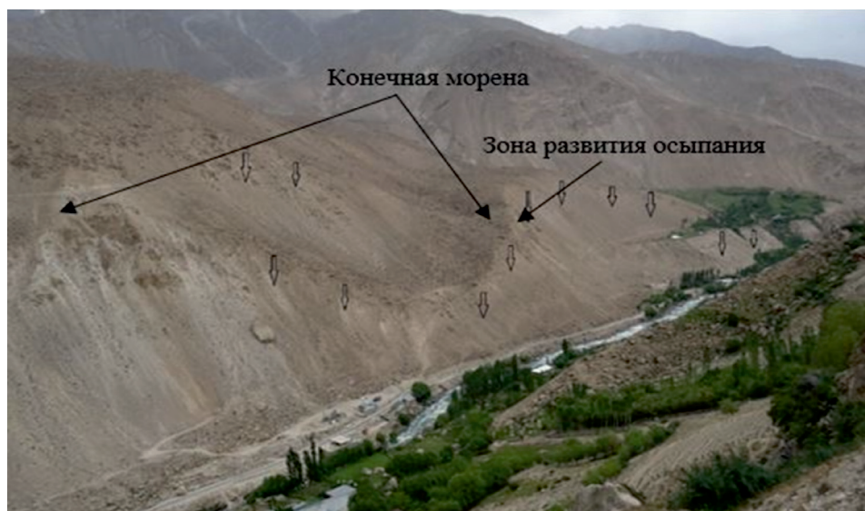
Рис. 24. Осыпной склон участка LS-7 в районе кишлака Чагев. Фото У.Р. Пирмамадова
