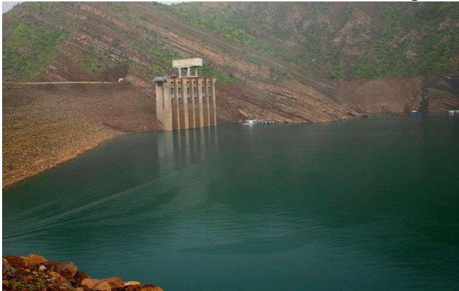
в – водоприёмник
