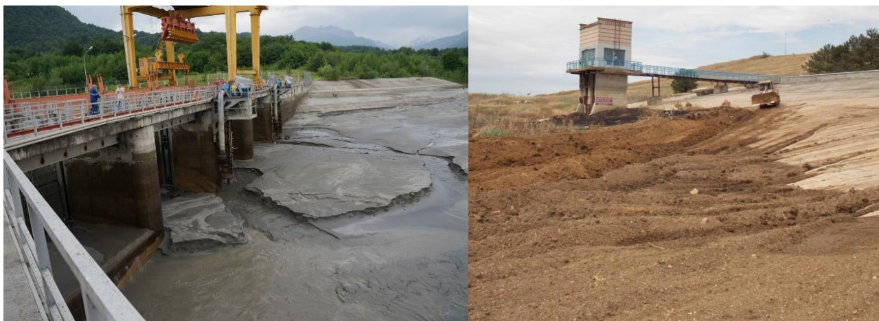
а б Рис. 1.6. Промыв от наносов гидроузла Кашхатау ГЭС на р. Черек (а) и очистка водохранилища Фронтное в Крыму от наносов и ила (б)
