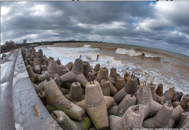
г – защита берега, Севастополь и пляжеудерживающие сооружения, Калининградской области
