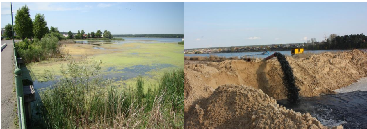
а б Рис. 1.5. Заиление водохранилища на реке Касмала Алтайского края (2014 г.) и его расчистка
