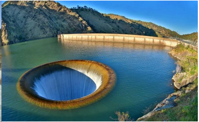
б – водосброс Саяно-Шушенской ГЭС и плотины Монтичелло в США
