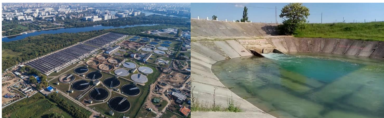
и – водоочистные сооружения в Курьяново (Москва) и Белогорское водохранилище в Крыму Рис. 1.2. Гидротехнические сооружения:
