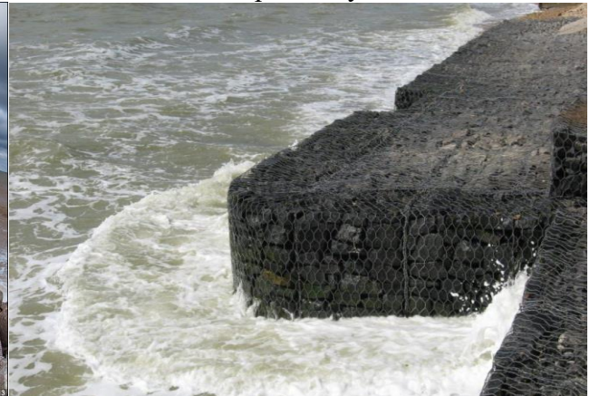
г – защита берега, Севастополь и пляжеудерживающие сооружения, Калининградской области
