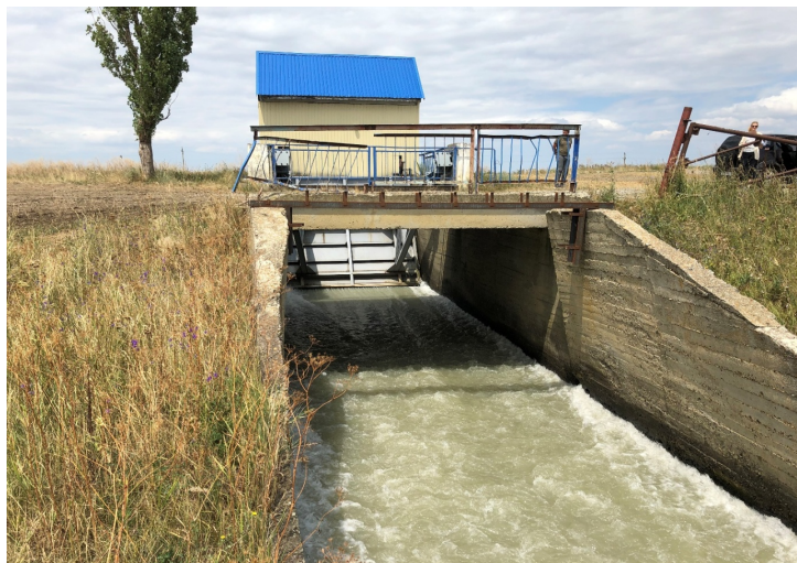
Рисунок 1 – Водовыпуск прямоугольного поперечного сечения с внутрихозяйственной дорогой над водоводом (автор фото В. Г. Дегтярев)
