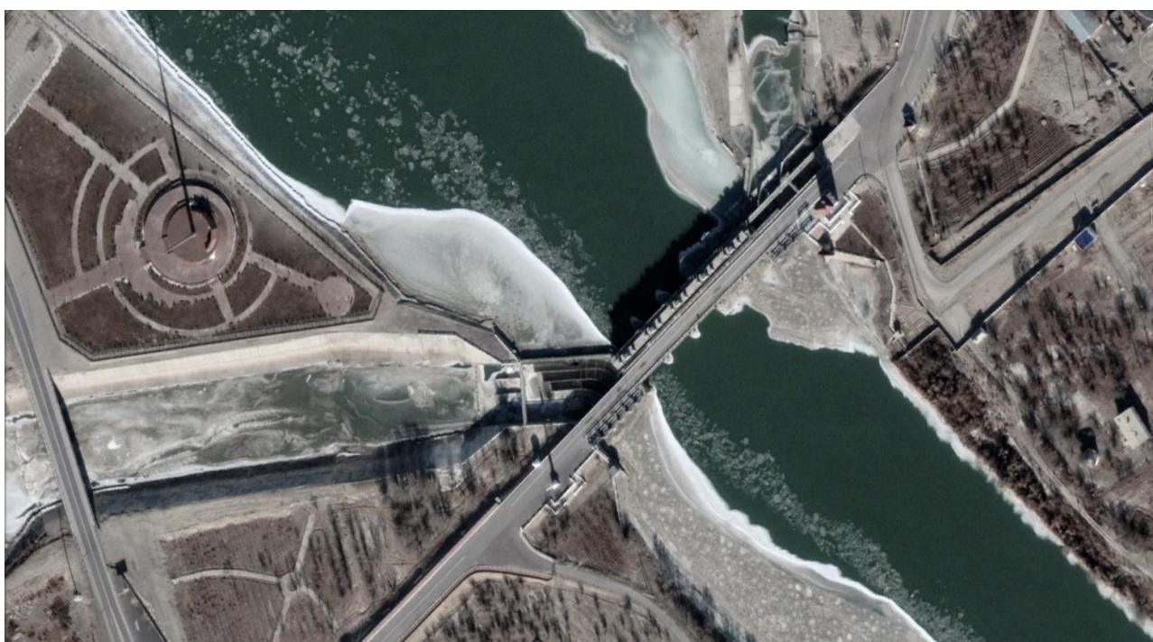
Рис.7.10. Ледовые явления на Кызылординском гидроузле.
