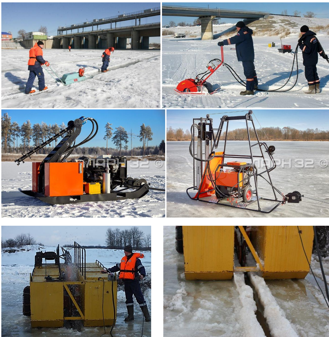
Рис.11.1. Механическое разрушение льда ледорезами различных типов.
