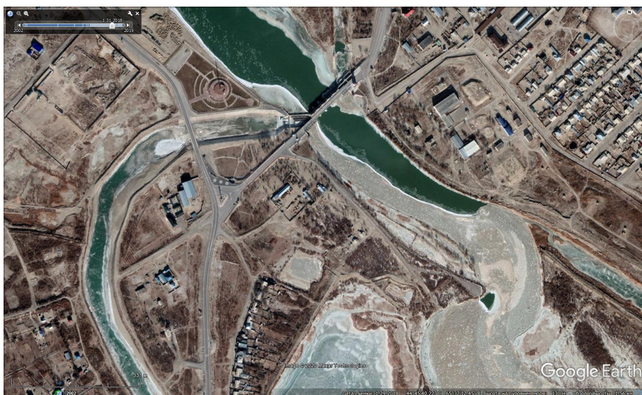
Рис.7.8. Ледовые явления на Кызылординском гидроузле.
