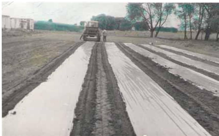
Фото 3 Механизированная укладка полиэтиленовой пленки
