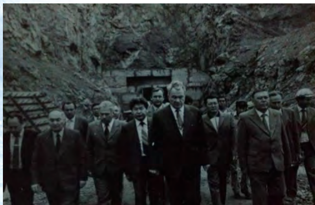
Руководство Казахстана на строительстве Бартогайского водохранилища на реке Шелек.
