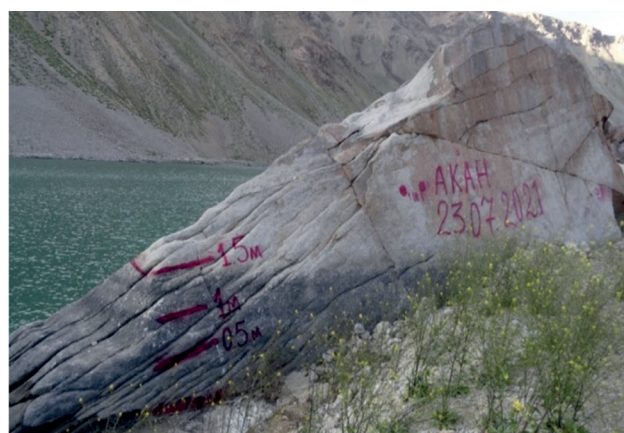
Рис. 27. Установленный футиток на озере Яшилькуль в районе завала с целью дальнейшего визуального измерения уровня воды в озере со стороны наблюдателей или просто населением к. Бурункул.
