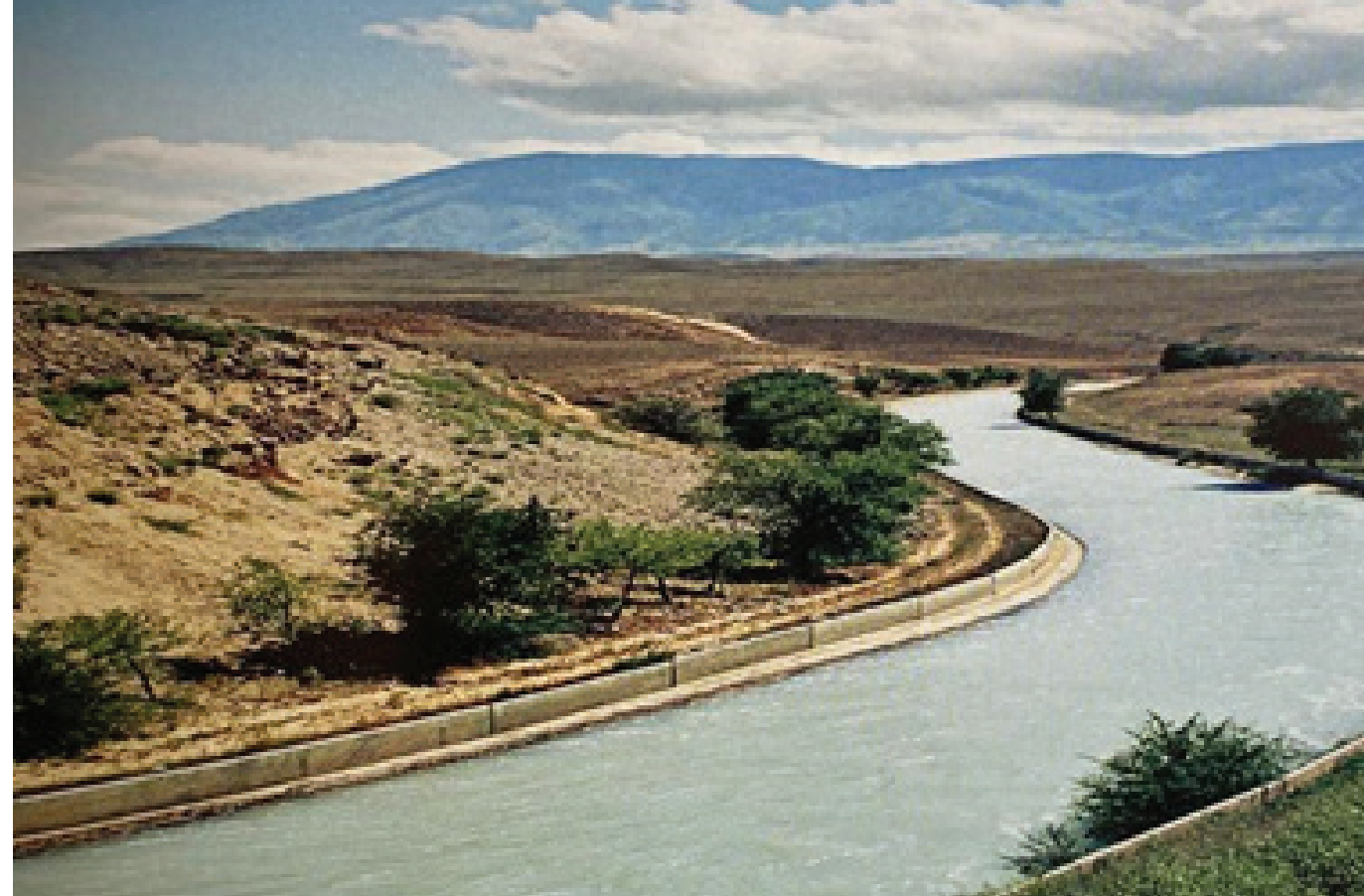
Большой Алматинский канал, 1983 г.
