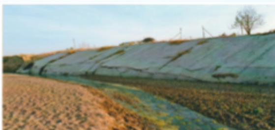
Деформация и разрушения облицовки канала в условиях затопления при-канальной полосы и высокого УГВ
