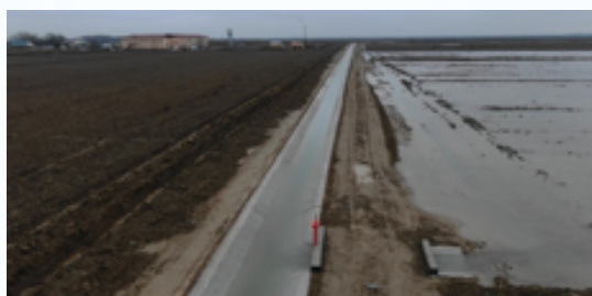
Фрагмент затопления при-канальной полосы при промывочных поливах с ненормированном режиме водоподачи
