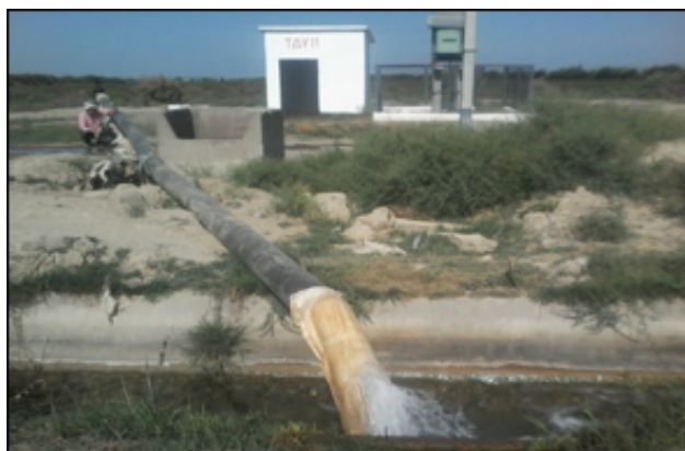
Рис. 6 - Использование грунтовых вод на орошение из СВД двойного действия
