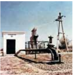
Скважина вертикального дренажа
