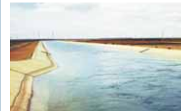
Канал в бетонном русле
