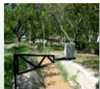
Установка датчика уровня воды на канале
