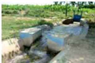
Гидропост с лотком САНИИРИ и регулирующим затвором в одной из базовых АВП проекта
