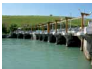
Кампирраватский гидроузел (Южно-Ферганский канал)
