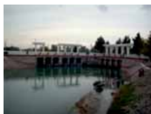
Хакулабадский гидроузел (БВО «Сырдарья»)
