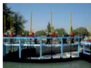
Гидроузел «Бешолиш» (Южно-Ферганский канал)
