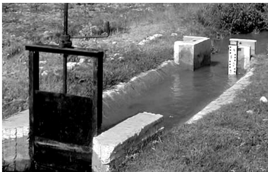
Рис.3. Гидрометрический пост, оборудованный лотком САНИИРИ, на одном из фермерских хозяйств пилотной АВП «Акбарабад»
