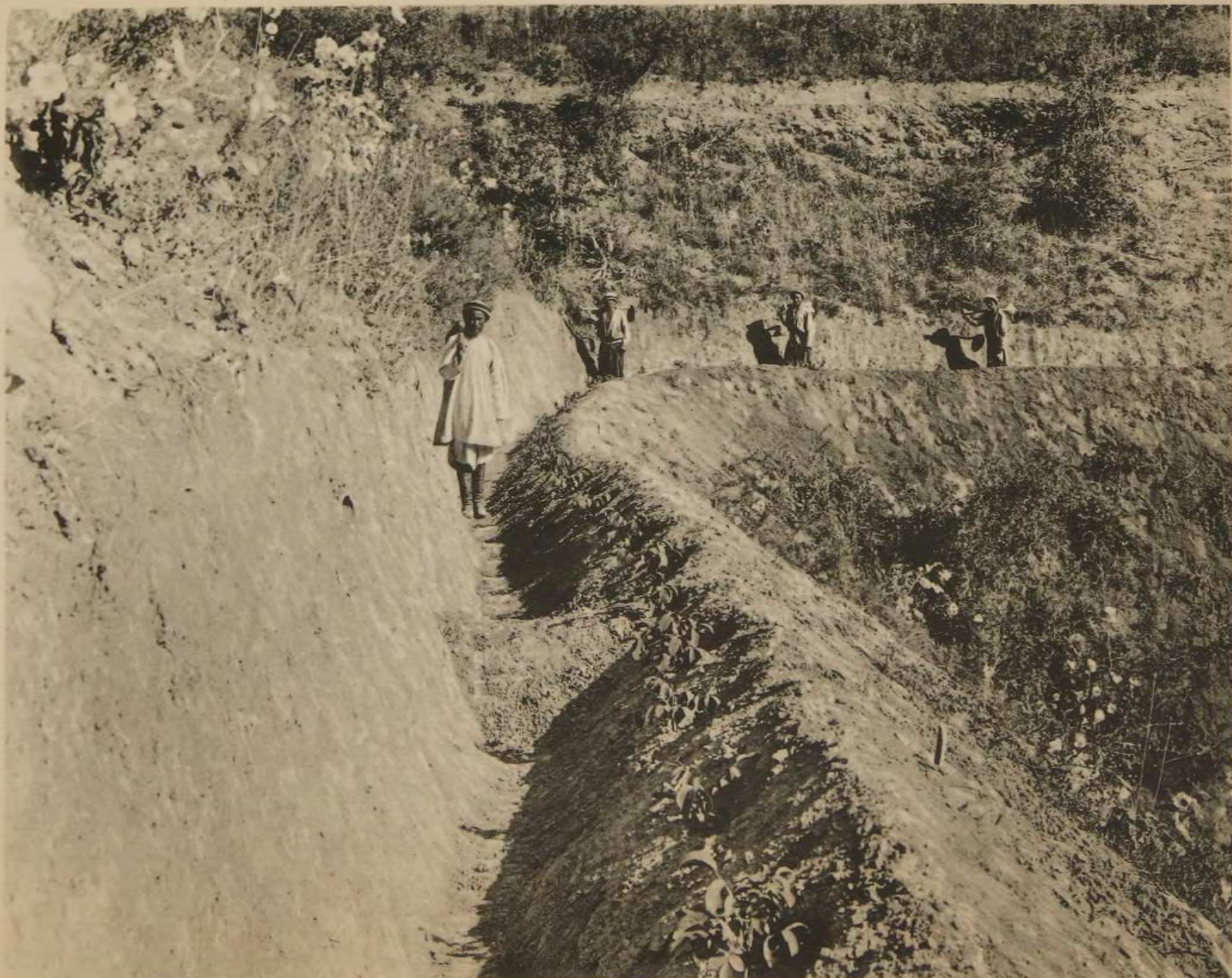
Терраса по горному склону въ 35°. Впереди первого, стоящаго въ канавѣ террасы рабочаго, видна перемычка террасы и видны посаженныя по валу террасы 1-лѣтніе саженцы грецкаго орѣха.
