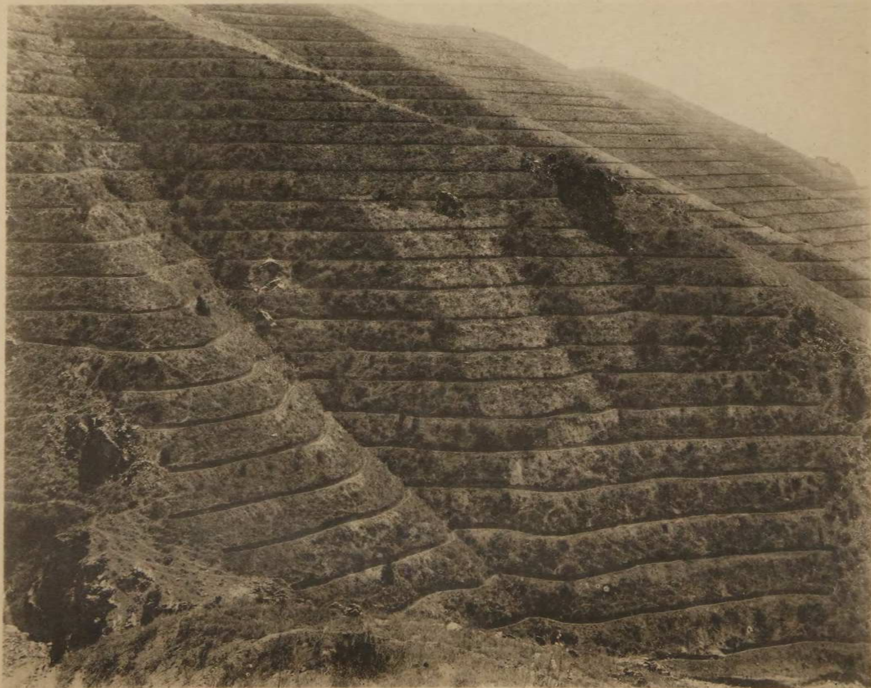
Террасировка горныхъ склоновъ въ 25-40^{\circ} , при разстояніи между террасами, по перпендикуляру, въ 3 саж.
