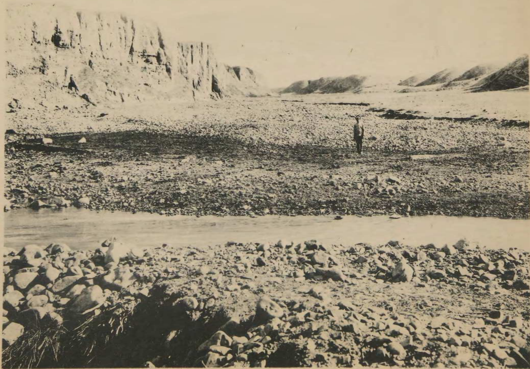
Русло р. Акъ-Ташъ и пересѣкающій его оросительный каналъ Искандеръ въ томъ мѣстѣ, гдѣ онъ разрушается силевымъ потокомъ Акташа.
