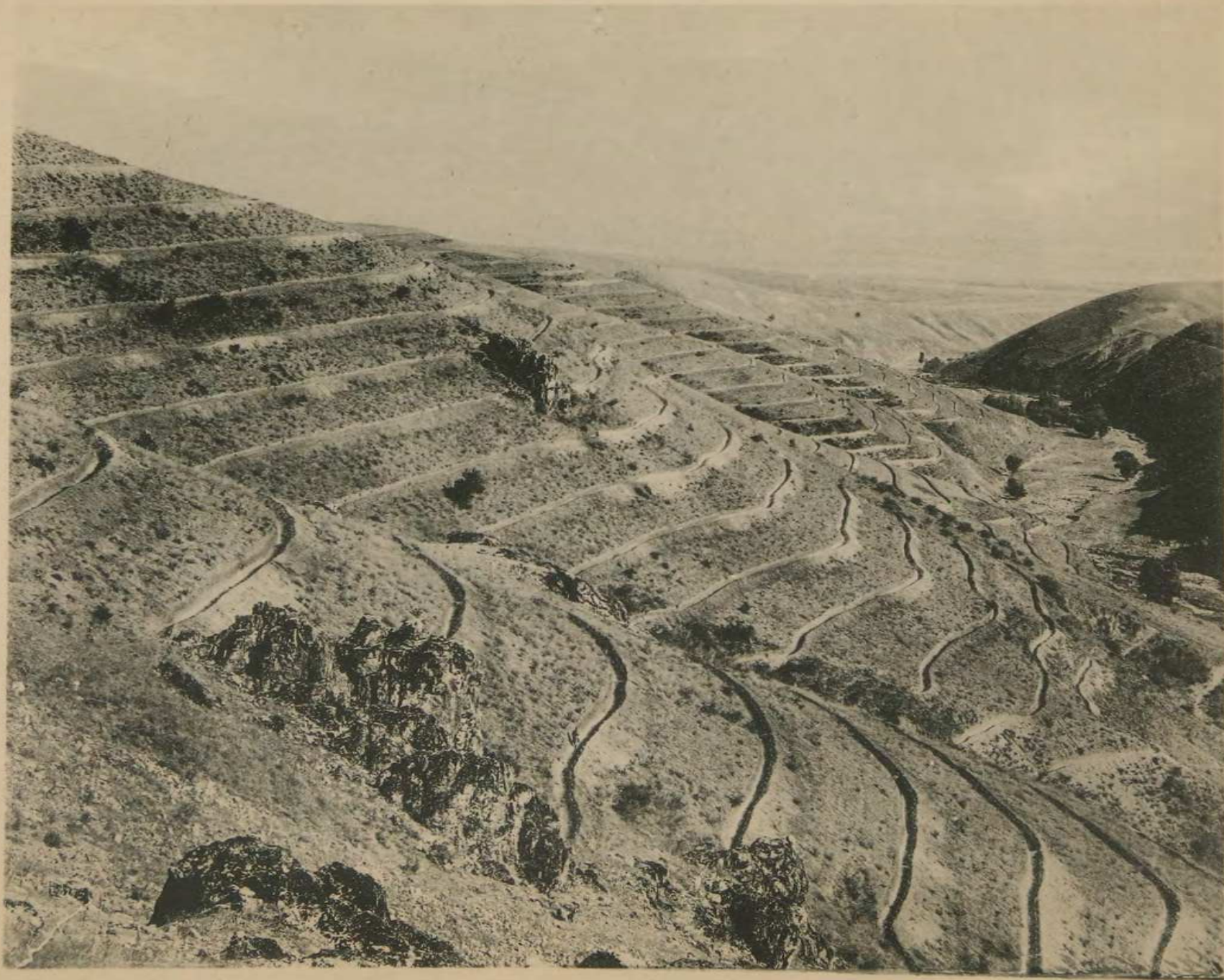
Террасировка горных склоновъ въ 15-25 0 при разстояніи между террасами, по перпендикуляру, въ 3 саж. Видъ на террасы сверху.
