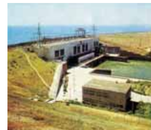
• Гидросооружение на Чардаринском водохранилище
