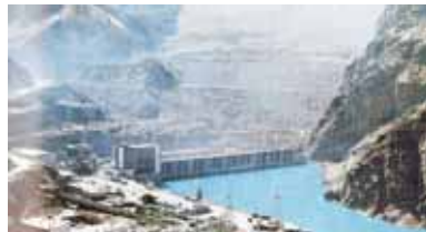
• Плотина Нурекской ГЭС
