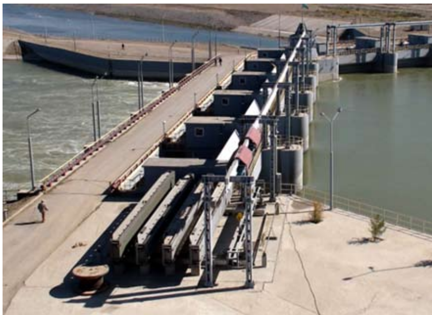
Рисунок 28 Головные сооружения Коксарайского контррегулятора
