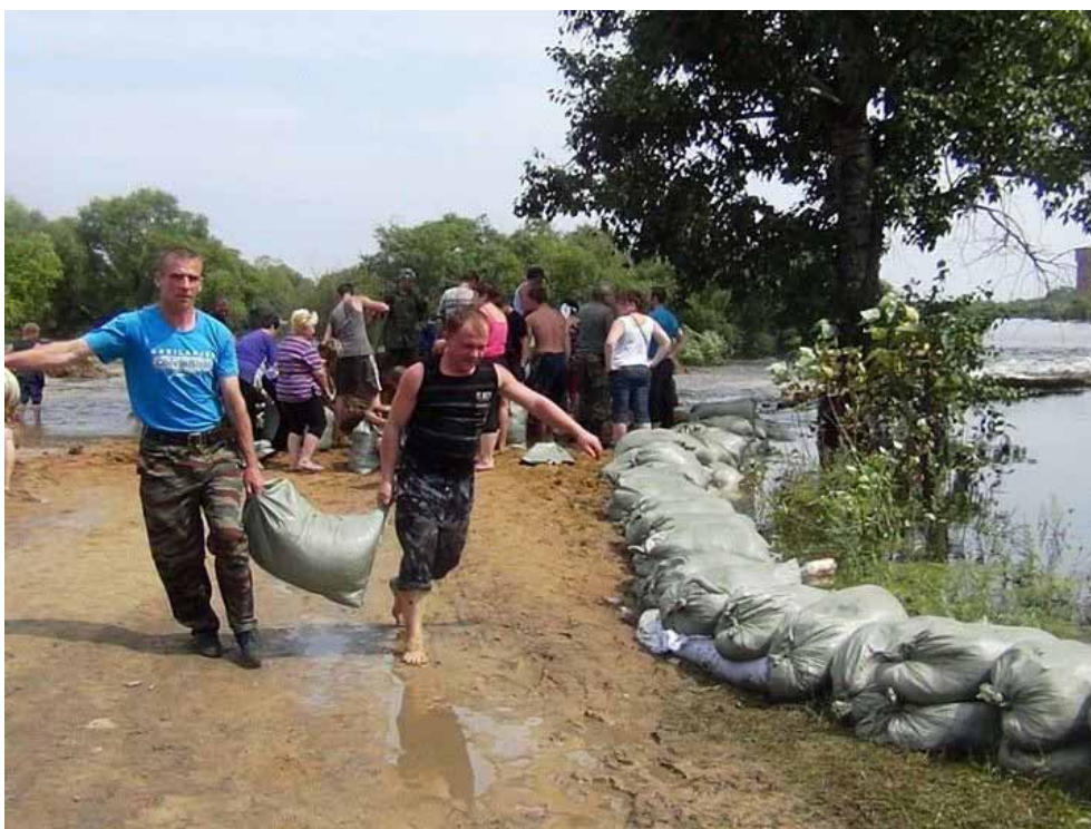
Рис. 1. Строительство защитных сооружений из песка 1950–2013 гг.
