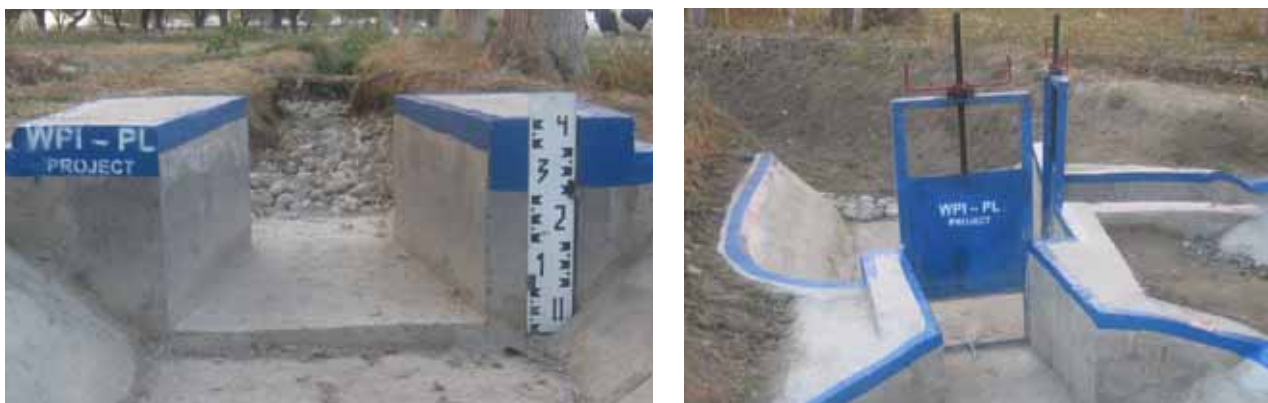
Рис.1. Гидрометрический пост с лотком САНИИРИ (слева), регулирующее сооружение (справа)
