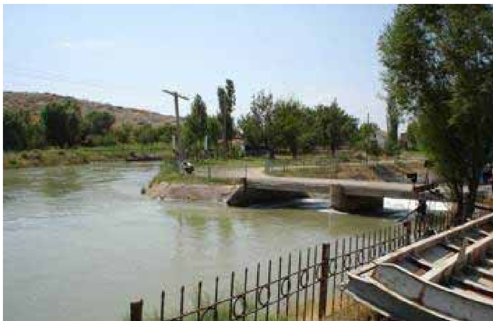
Рис.4. Отвод из ЮФК для деривационной ГЭС
