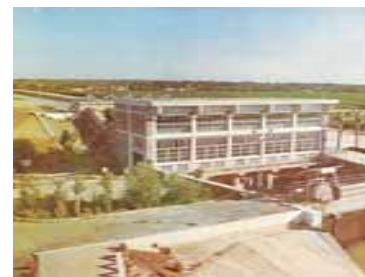
Абдусаматская насосная станция на р. Сырдарье
