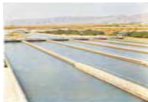
Газалкентский гидроузел. Отстойные камеры
