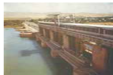
Плотина на р. Чирчик. Газалкентский гидроузел
