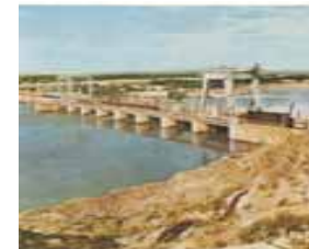
Фархадский гидроузел на р. Сырдарье
