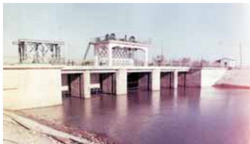
Головное сооружение канала Туранга Сака
