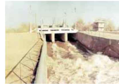
Подпитывающее сооружение на 42 км канала Шаватской ветки
