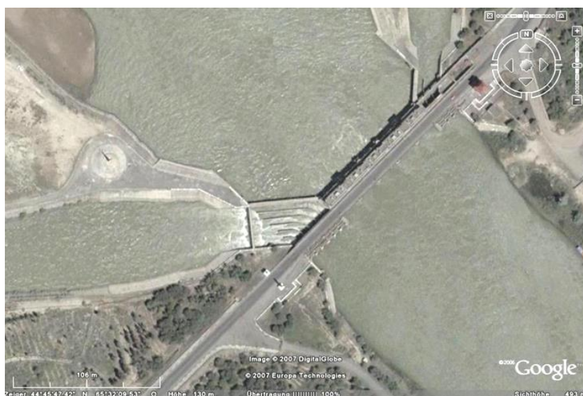
Рис. 3.8. Реконструкция левобережного шлюза-регулятора Кызылординского гидроузла
