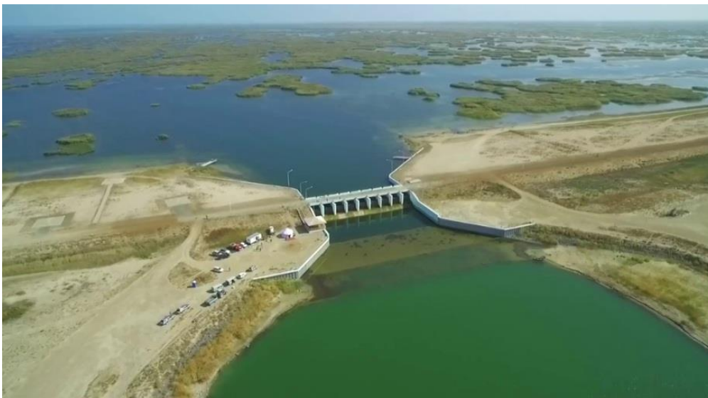
Рис.3.5 Плотина Северного Аральского моря
