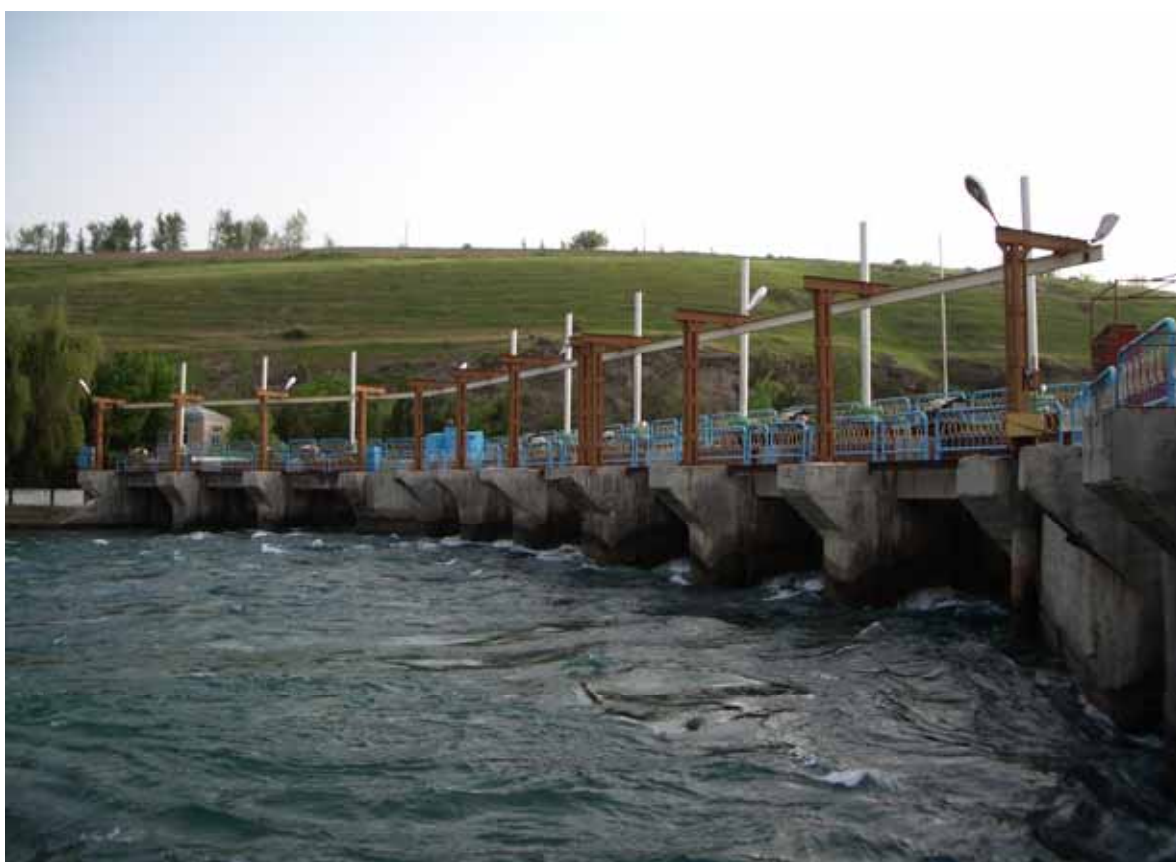
Комплекс сооружений Андijanского водохранилища. Кампырабадский водный узел
