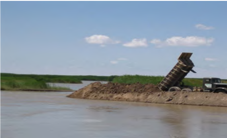
Строительство бортового водослива на Восточной дамбе Междуреченского водохранилища
