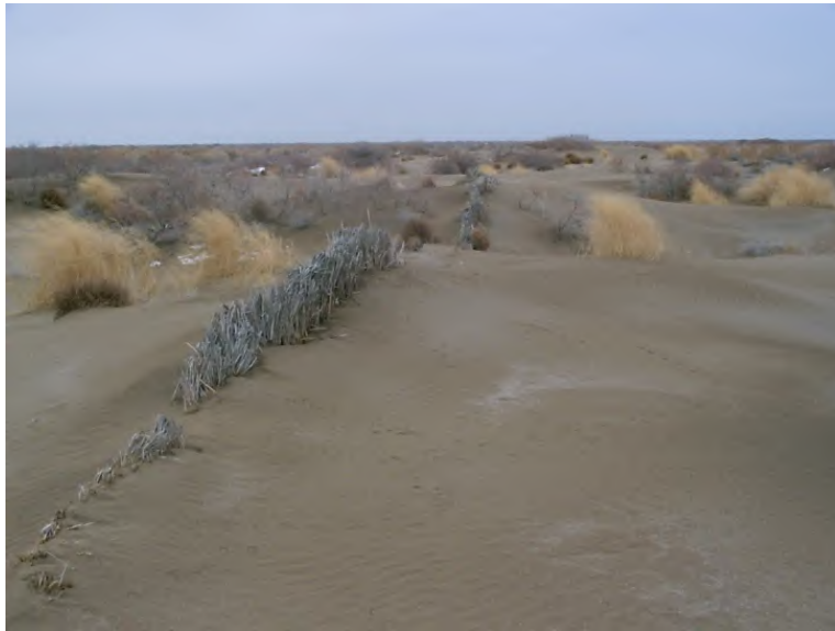
Устройство стоящих мехзащит из камыша
