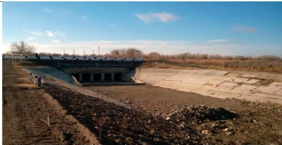
Вид с нижнего бьефа
