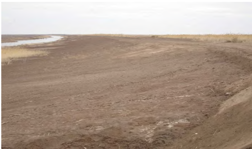
Муйнакский залив. Западная дамба. Протяженность 8,4 км. Год ввода в эксплуатацию 2003г. Стоимость объекта 502285,0 т.с.
