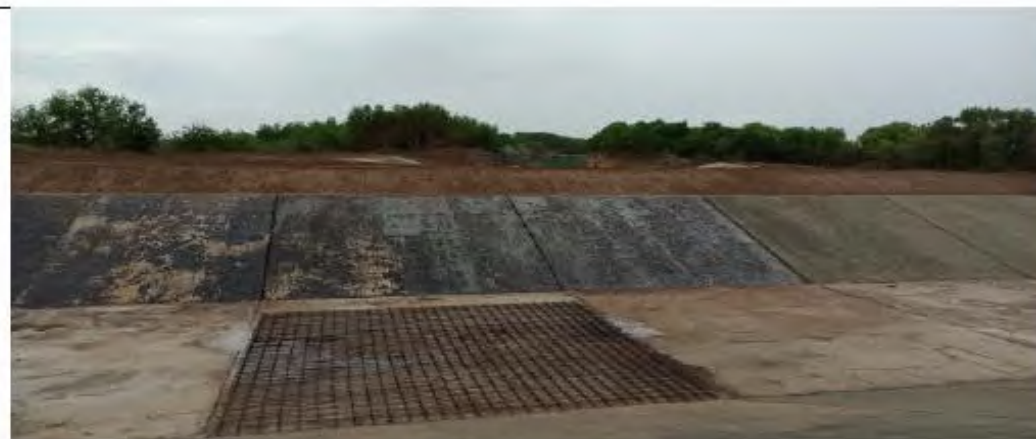
Канал Муйнак над дюкером
