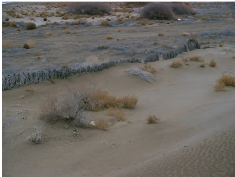
Устройство стоящих мехзащит из камыша
