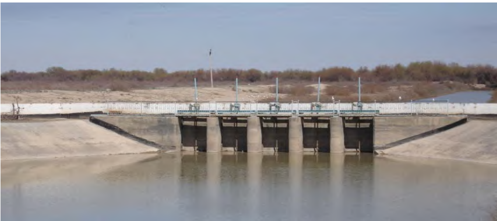
Междуреченское водохранилище. Водовыпуск на канале «Муйнак» 44\text{ м}^3/\text{с} . Год ввода в эксплуатацию 2002г. Стоимость объекта 172433,0 т.с
