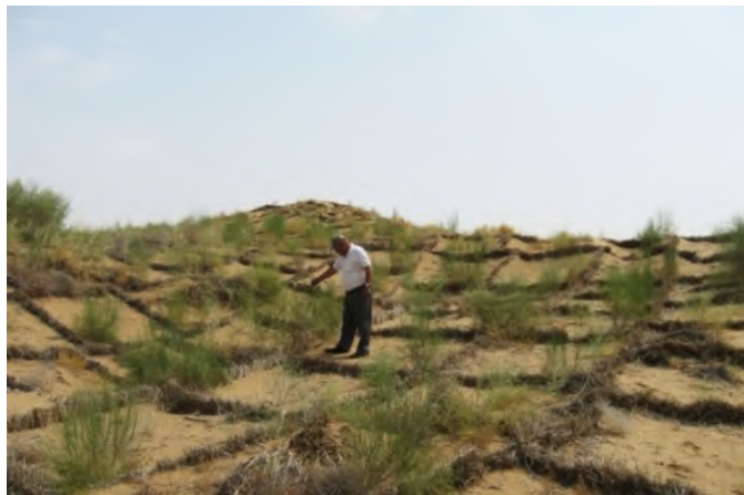
Фиксация движущихся песков камышовыми сетками мехзащиты
