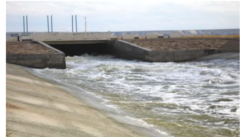
Озеро Судочье. Водовыпуск Аккумской дамбы на 55 м 3 /с (верхний и нижний бьеф).
