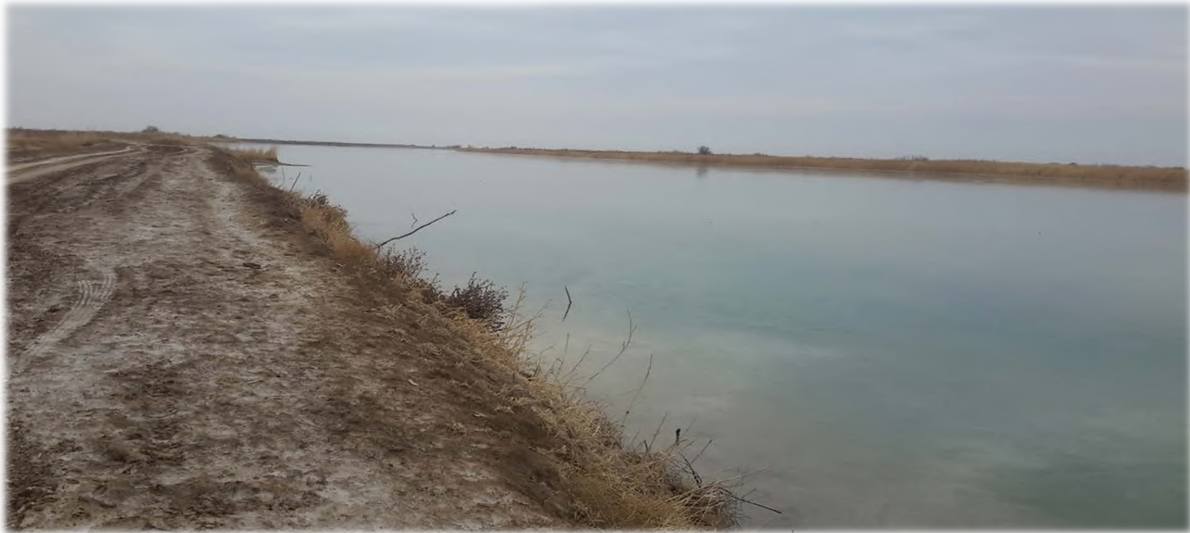
Восточная дамба (вид верхнего бьефа в начале дамбы)
